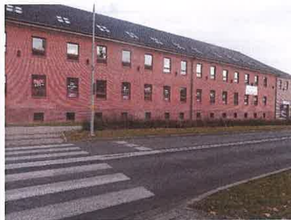
Budynek mieszkalno-usługowy ( działka 682)
